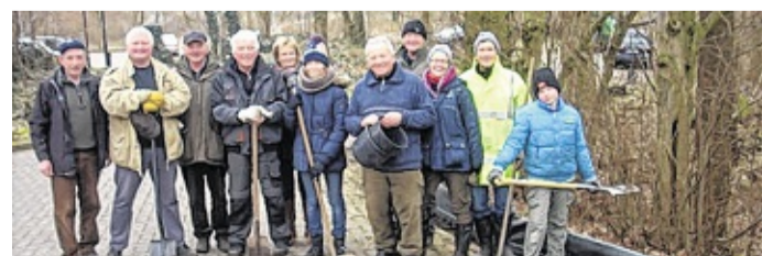
Jersbeker Naturschützer haben einen Schutzzaun zwischen Schlossteich und dem Wäldchen am Oberteicher Weg errichtet. Foto: hfr
