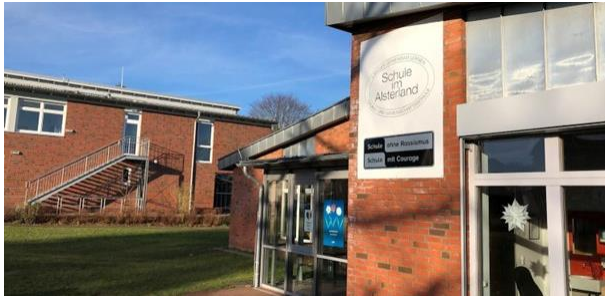
NaWi-Gebäude und Stillerraum
